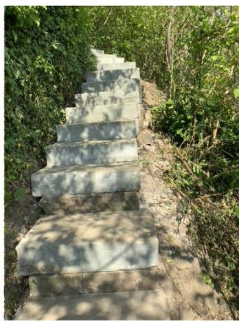
Die zweite Bau-Etappe im Rebberg Bäremannli, nämlich die Sanierung der Steintreppe zwischen der unteren und oberen Parzelle, konnte dieses Jahr ausgeführt werden. Diese Treppe war baufällig und enorm gefährlich und musste dringend repariert werden. Die Arbeiten wurden von der Fa. Steger Gartenbau bestens ausgeführt und im April abgeschlossen.
